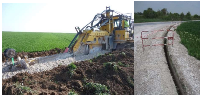
Photo 12 : Exemple de tranchée réalisée (Source : TotalEnergies)
